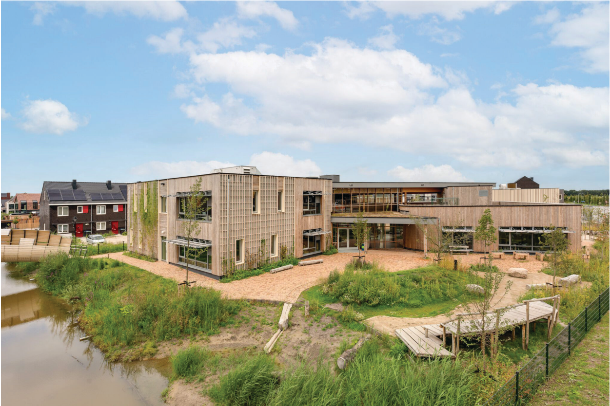
Figuur 1.2.2 Biofilische school De Verwondering - Exterieurbeeld (ORGA Architect, z.d.)
