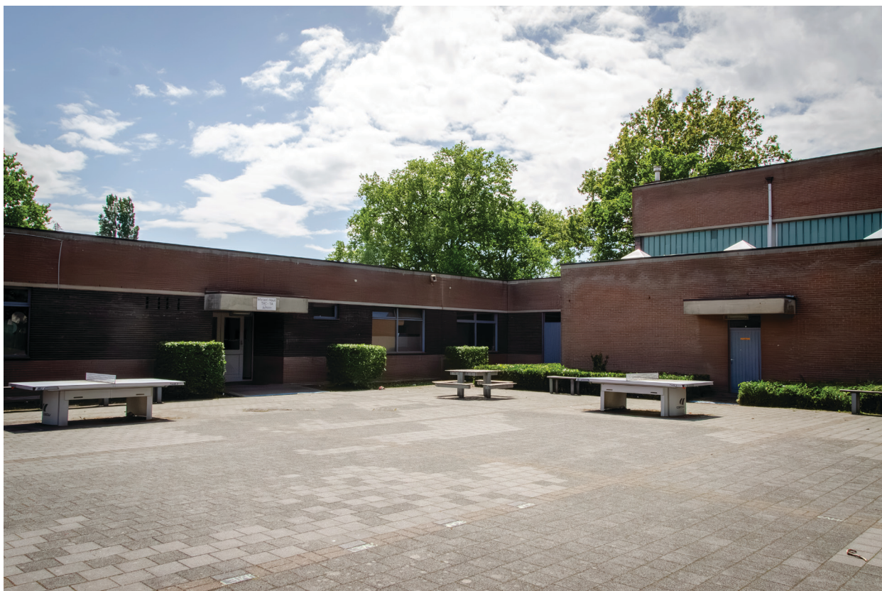
Figuur 2.21 Verharde speelplaats met sporthal (Standpunt 19)
