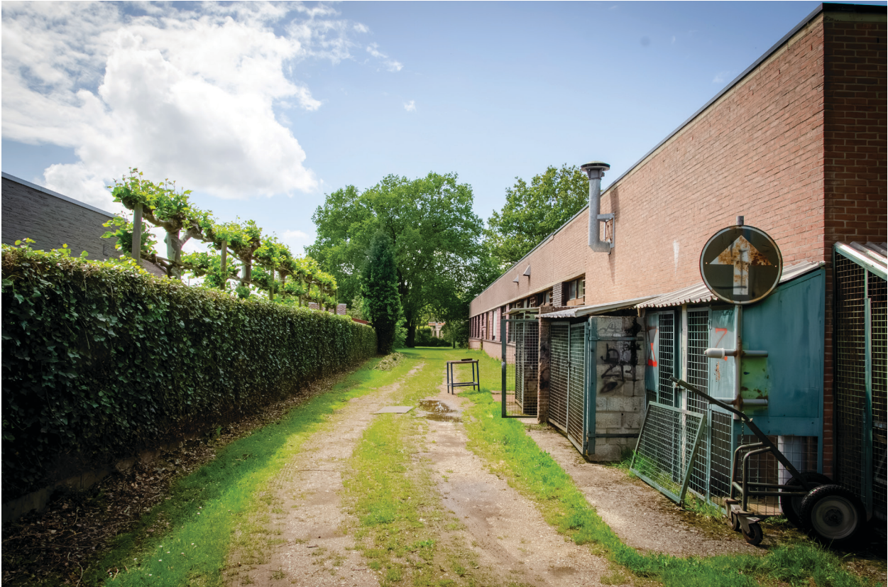
Figuur 2.27 Relatie omliggende woning en achterkant De Wilg (Standpunt 25)
