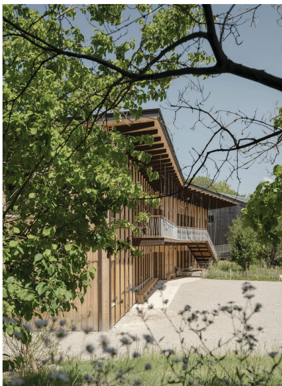
Figuur 2.37 Extérieur van de uitbreiding van de Steiner School in Bois-Genoud
