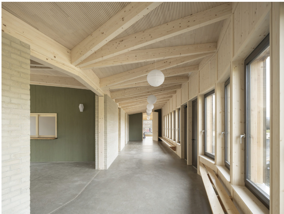
Figuur 2.36 Interieur van de uitbreiding van de Steiner School in Bois-Genoud
