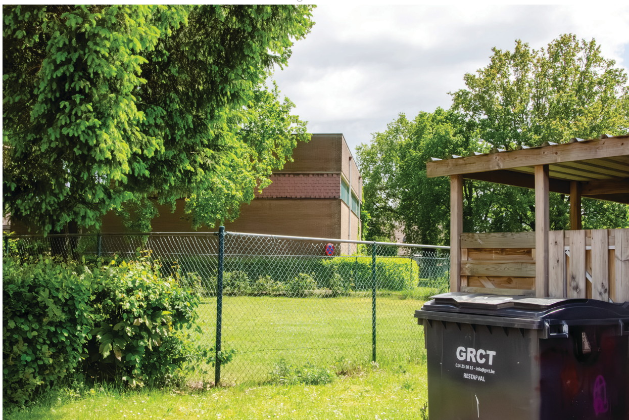
Figuur 2.18 Speelplaats afgesloten met hekwerk (Standpunt 16)
