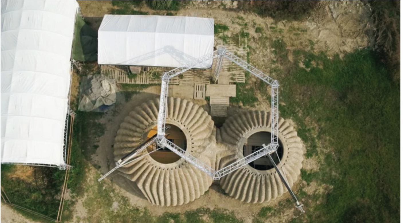
Figuur 1.17: Proces 3D-printen van gebouw - (M.c. architects, 2025)
