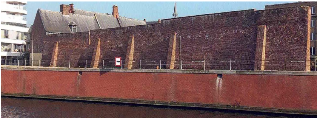
Afbeelding 8: Overblijfsel van de stadsmuur ter hoogte van het O-L-Vrouwehospitaal (Callewier) 490
