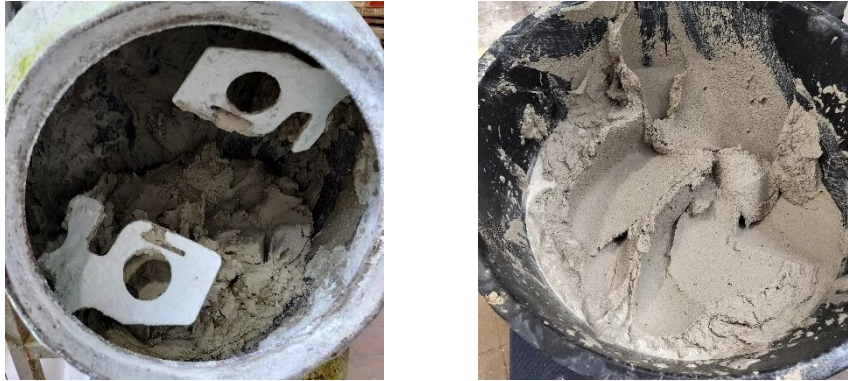
Figuur 50: Aanmaak van de bastaardmortel in de betonmixer en rechts de finale, gladde specie.
