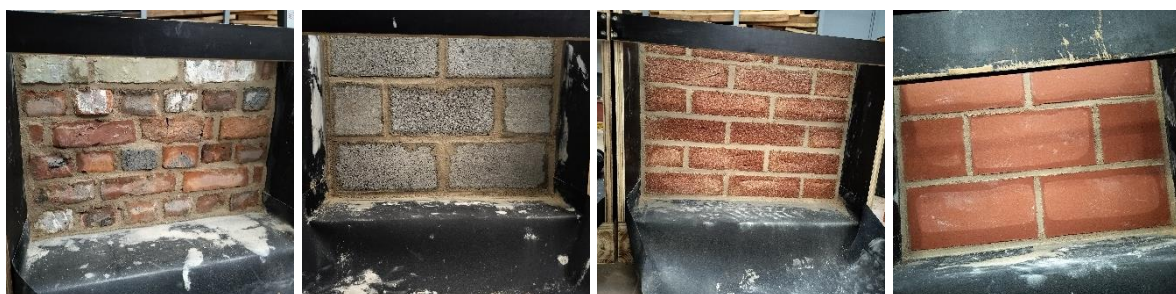
Figuur 55: Kringvormige patronen op het metselwerk na het metselen door onttrekken van vocht aan de mortel.
