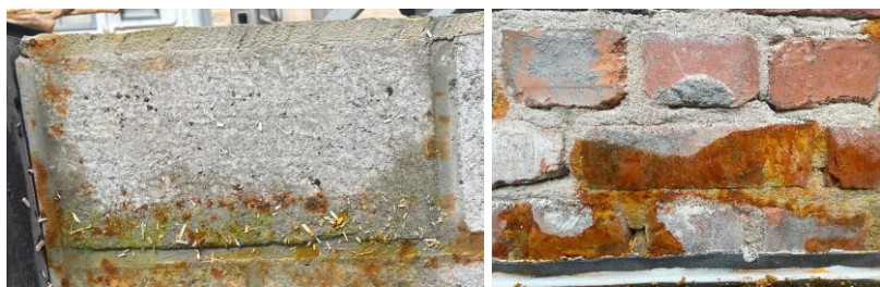
Figuur 78: Golfvormig patroon in de steen met grotere stijghoogte nabij de voegen a.g.v. capillaire absorptie.
