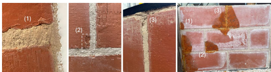
Figuur 84: KALK 2 - scheuren en een gebroken hoek van een steen leiden tot lokale infiltratie aan de achterzijde.
