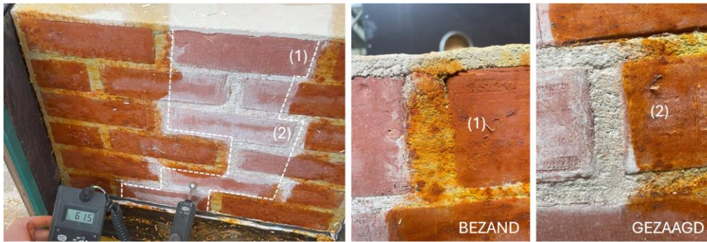
Figuur 82: Zaagtandpatroon (links), verschil tussen voeg tegen bezande kant en gezaagde kant (rechts).
