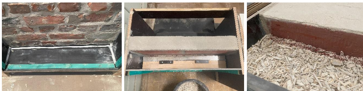
Figuur 56: V.l.n.r. verlijmde EPDM-opstand, aandammen van de kalkhennep en plaatsing van de kleurstofkorrels.
