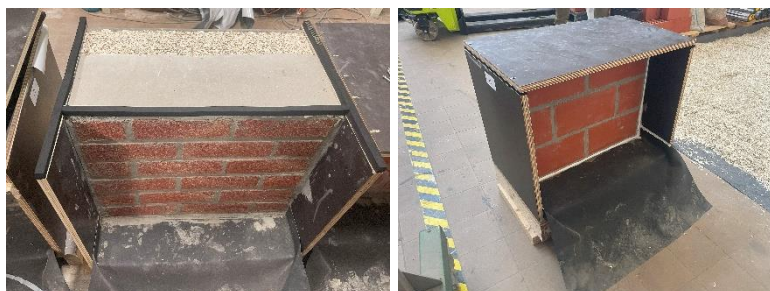
Figuur 57: Het aanbrengen van zwelband bovenaan en tot slot de afgewerkte testkast.
